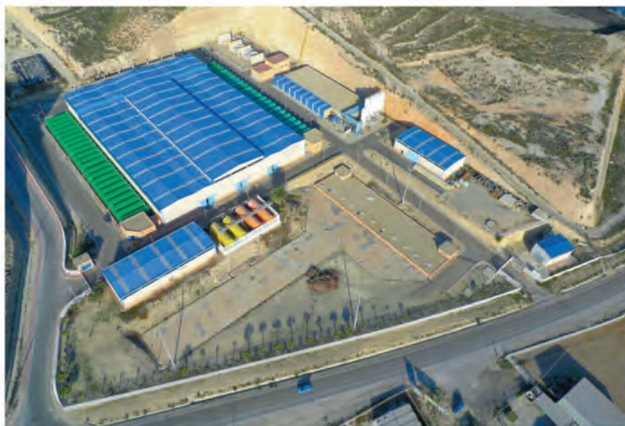
Fotografía de la planta desaladora de Carboneras (Almería). Cedita a AEDyR por GS Inima.
