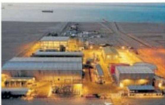
Planta de desalación de Tedagua para Mina Spence (Chile)
